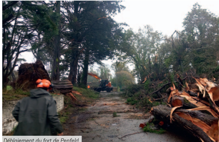
Déblaiement du fort de Penfeld
