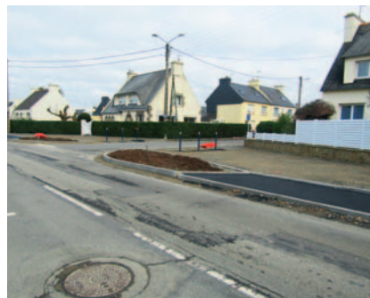
Pose des bordures et enrobé des trottoirs
