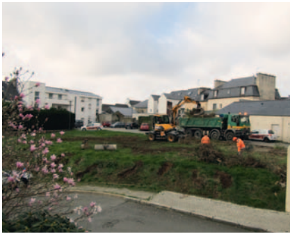
Déblaiement du terrain
