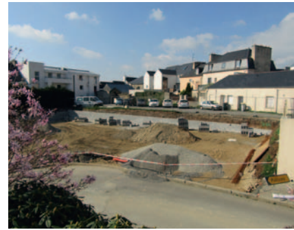
Création du mur de soutènement
