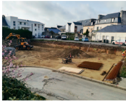
Décaissement et terrassement du terrain
