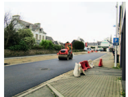
Enrobé de la chaussée
