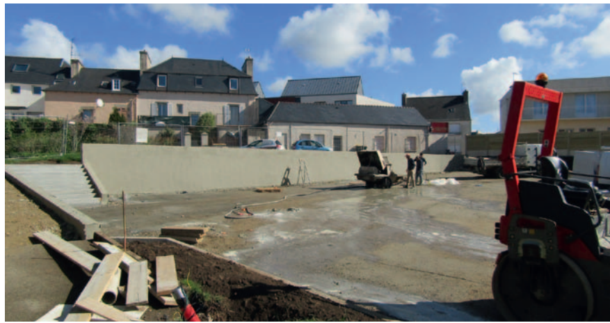
Décaissement et terrassement du terrain
