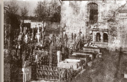
Clocher démolì de l'église de Guilers
